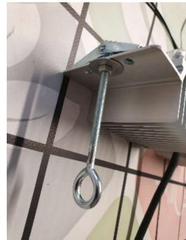
*Schritt 3: Gewindestangen montieren*
