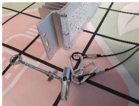
*Schritt 2: Gewindestangen positionieren*
